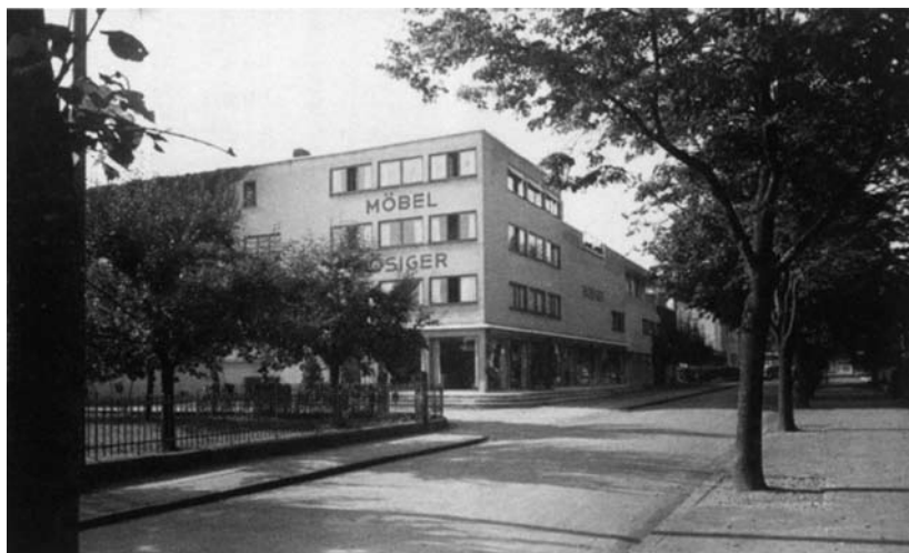
Die Fassade mit dem Verkaufsladen an der Mittelstrasse.
